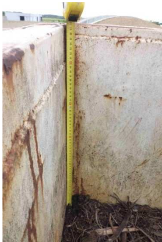
Photo 12 : mesures des tassements (pilote C)
