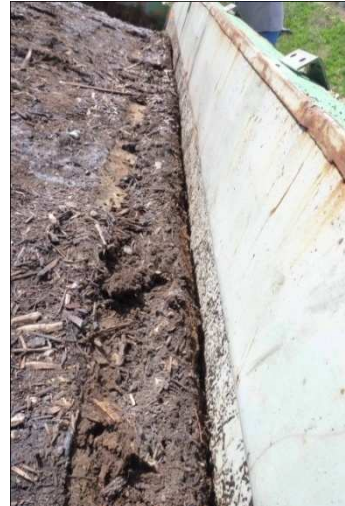
Photo 11 : espacements et tassements côté gauche (pilote C)
