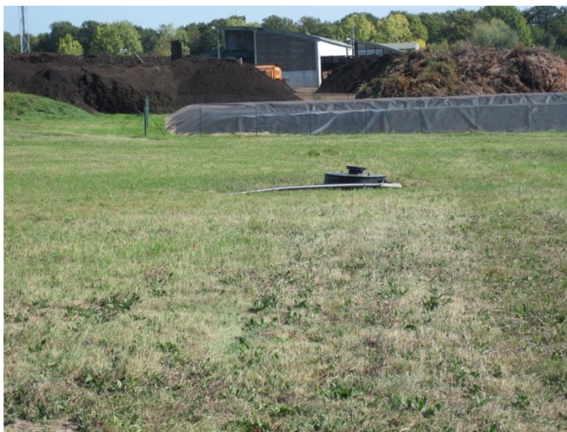
Figure 10 : Vue de la zone réaménagée avant 1997, vers le bassin des lixiviats, 09/2011
